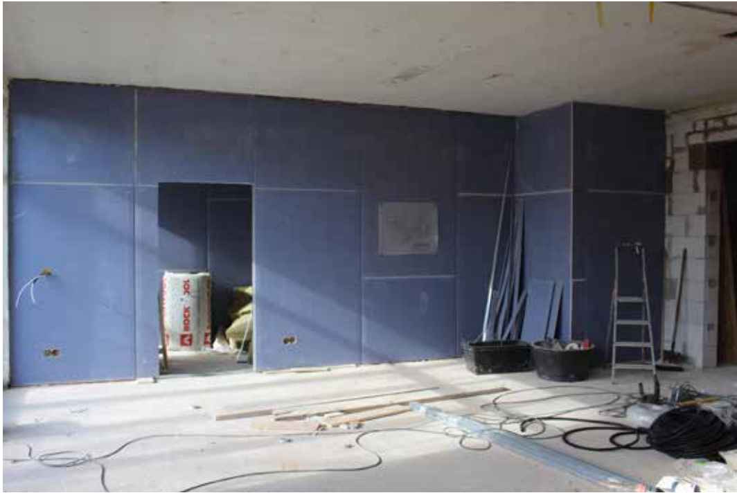
Kindergartenerweiterung: Blick aus dem Turmraum auf die Trennwand für Nebenräume
